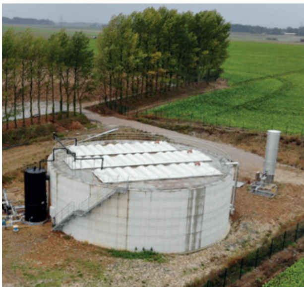
La chaudière biogaz de la sucrerie de Cristal Union à Fontaine-le-Dun (76)
