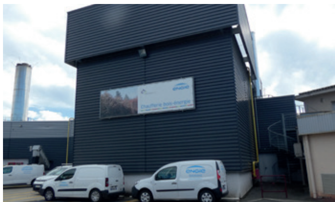
Chaufferie biomasse de l'Hôpital de Périgueux (24)
