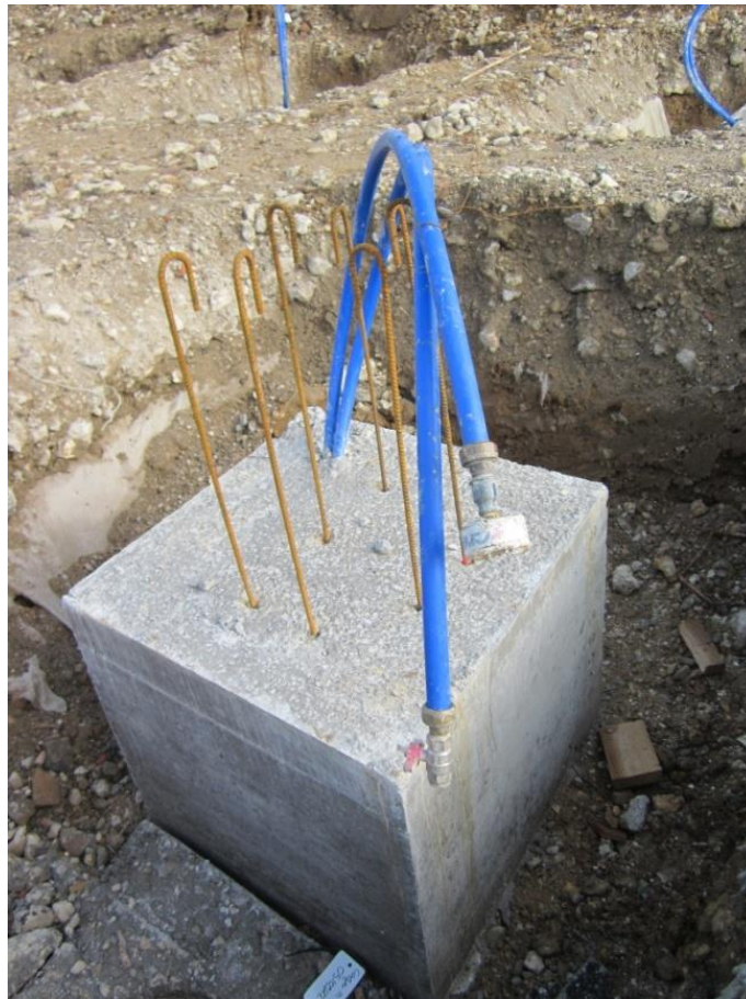
Figure 53 : tête de pieux (Géothermie-Professionnelle/Pinto)
