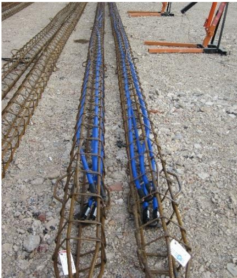
Figure 48 : Pieux énergétiques de petit diamètre (Géothermie-Professionnelle/Pinto)
