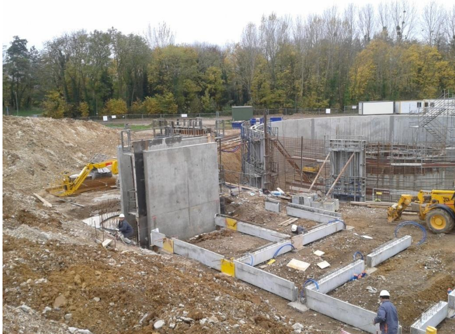
Figure 54 : tête de pieux (Géothermie-Professionnelle/Pinto)
