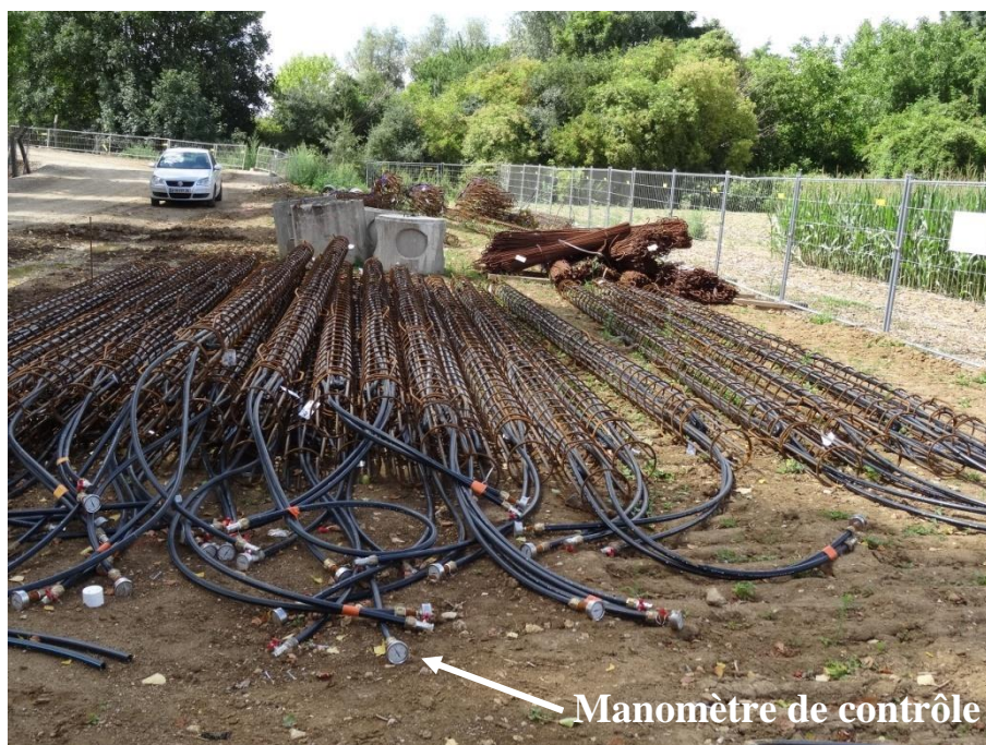
Figure 52 : manomètre de contrôle (Géothermie-Professionnelle/Pinto)
