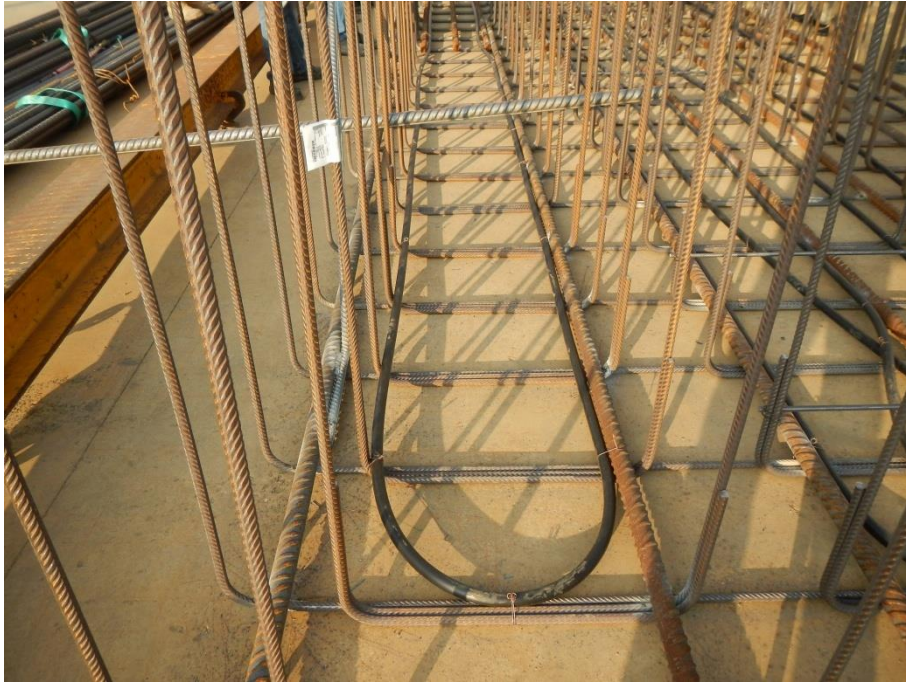
Figure 55 : paroi moulée équipée de tubes géothermiques (Géothermie-Professionnelle/SYSTR)
