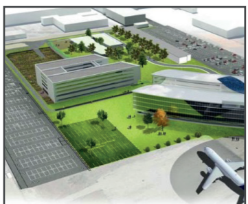
Blagnac - Campus Airbus Group 2MW sur boucle tempérée couplée à 140 sondes de 205m
