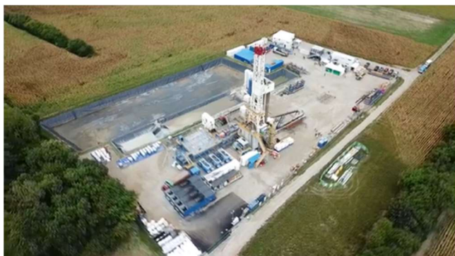
Figure 4: Illkirch drill site in Alsace (Electricité de Strasbourg)
